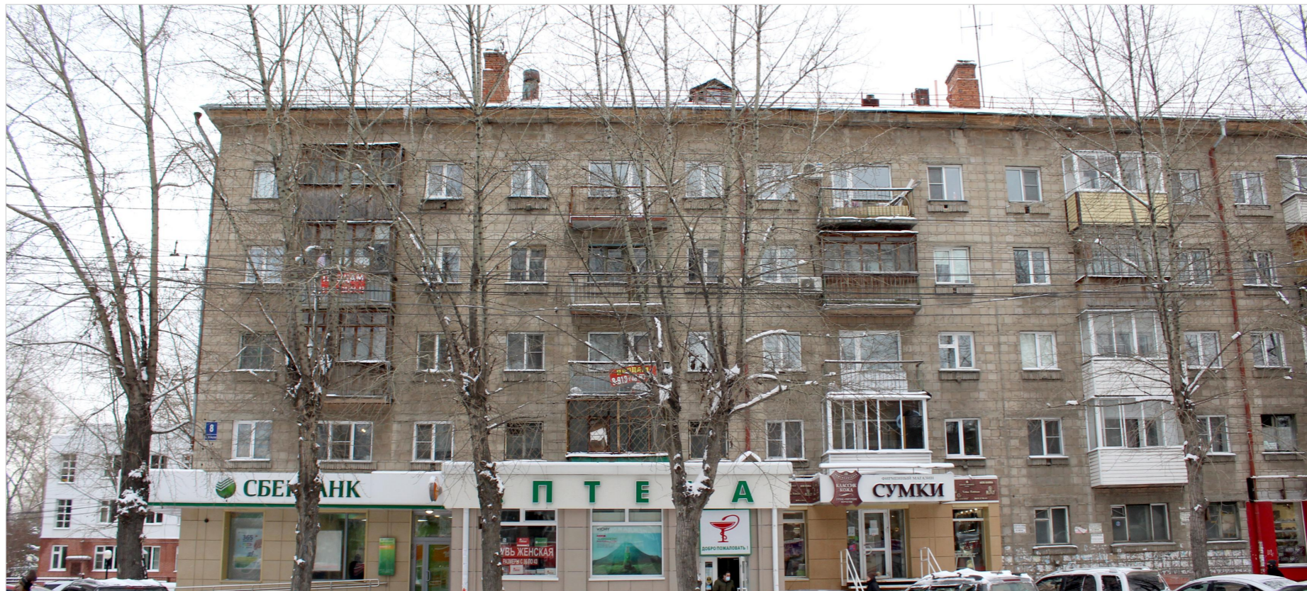
Главный фасад 1-13, выходящий на проспект Карла Маркса
